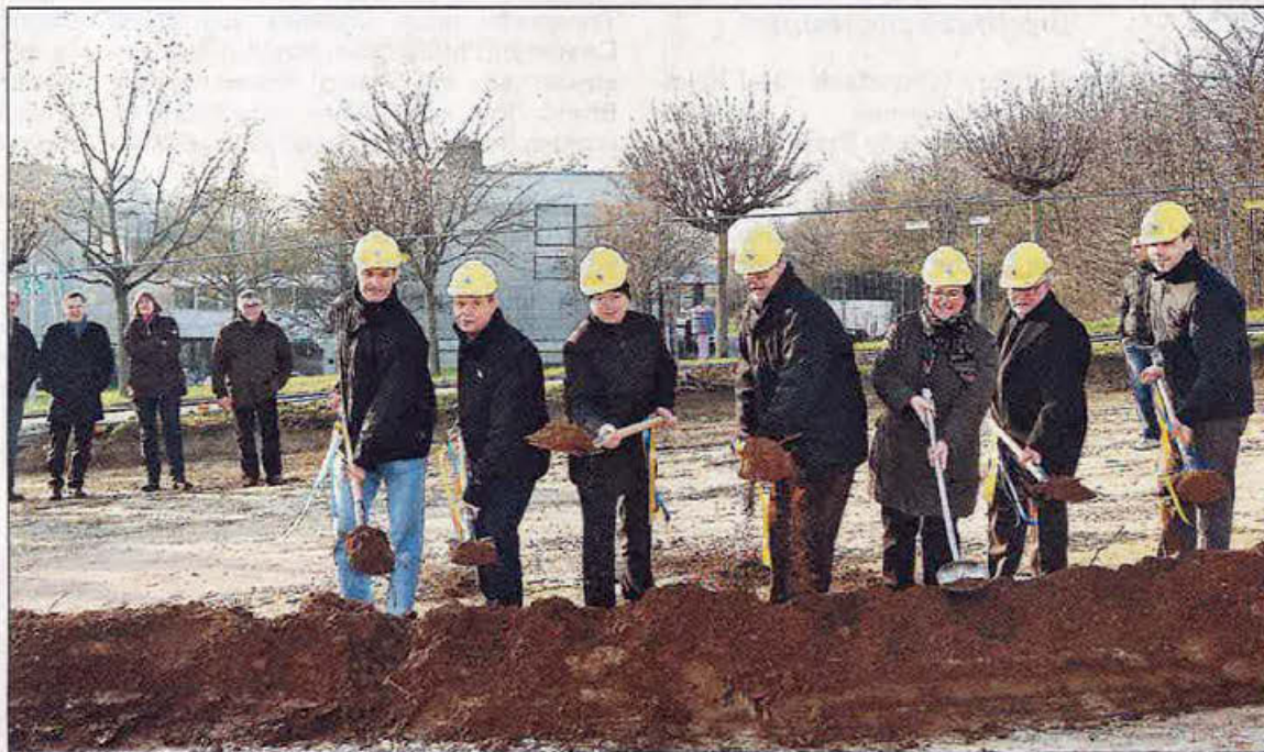
Vorfreude herrschte beim Spatenstich zum Neubau einer Großküche am PZN, die schon in einem Jahr in Betrieb gehen und über 4000 Essen am Tag ausgeben soll. Foto: Pfeifer
